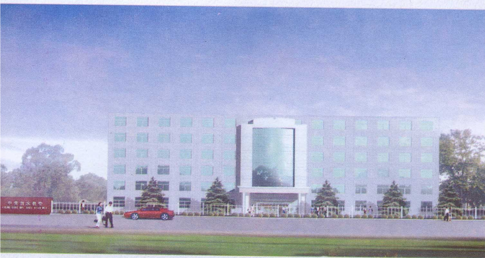
中共白水县委办公楼
