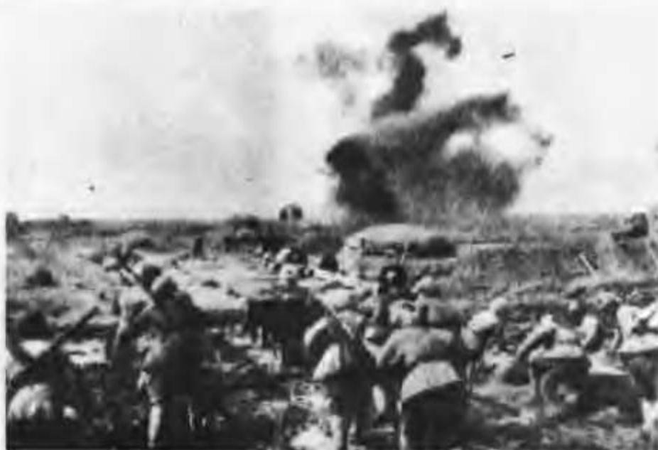
架桥组在炮火掩护下，扛着用芦苇绑扎的浮桥前进（天津战斗）。
